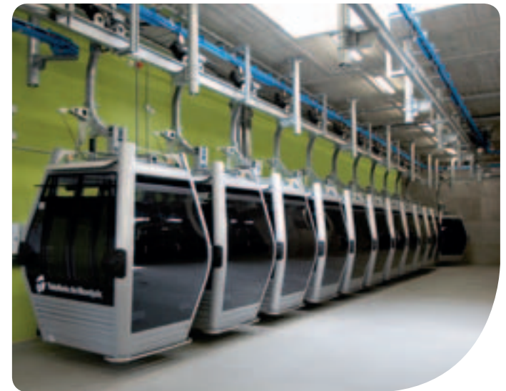
De petite ou de grande taille, les cabines sont contrôlées quotidiennement et abritées chaque nuit dans un atelier sécurisé.
